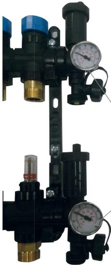
Las temperaturas de agua de impulsión en colector hacia los circuitos y de retorno de los mismos puede leerse en los termómetros del colector.
